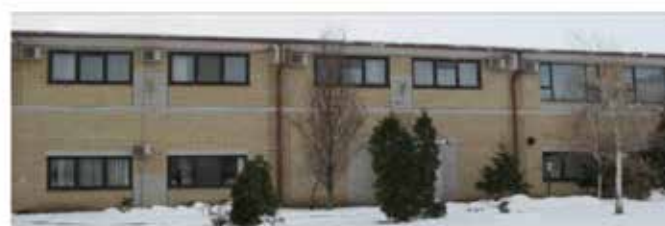
Termovizijska analiza gubitaka
